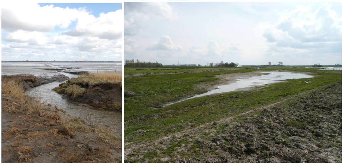
Abb. 4: Links: Maßnahmen zur Erhöhung bzw. Wiederherstellung des Tideeinflusses. Mündung eines neu angelegten Priels im Maßnahmensgebiet Allwörderer Außendeich in die Elbe, 26.03.2008 (Foto: Eva-Maria Bauer) Rechts: Vertiefung und Aufweitung einer bestehenden Tidemulde auf Vordeichsflächen der Hetlinger Binnenelbe im Maßnahmensgebiet Hetlingen/Giesensand, 15.04.2008 (Foto: Dr. Andreas Sundermeier)
