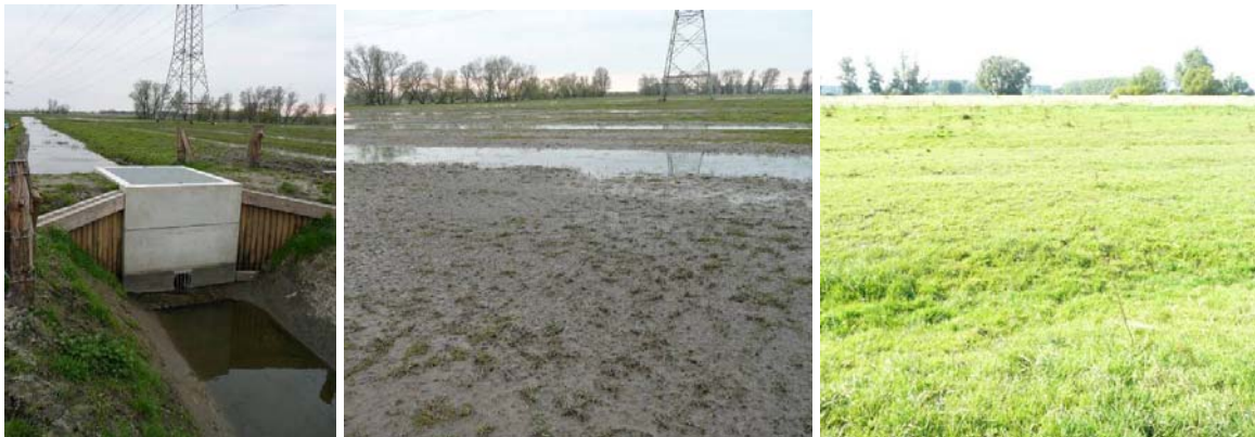
Abb 2: Links: Regelungsbauwerk zur Steuerung der Vernässung im Maßnahmengebiet Hetlingen/Giesensand, 14.04.2008 Mitte: Parzelle im Einflussbereich des Regelungsbauwerkes nach der ersten Wintervernässung, 14.04.2008 Rechts: Neu aufgewachsener Straußgras-Flutrasen im Sommer nach der ersten Überstauung, 28.07.2008 (Fotos: Dr. Andreas Sundermeier)
