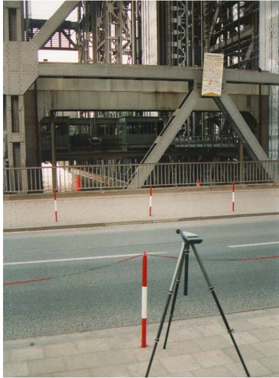
Abbildung 17: Messung mit dem Schiffsbetrieb verbundenen Schallemission eines Schiffshebewerks
