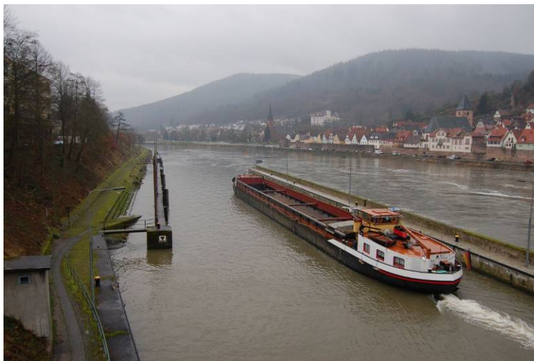
Abb. 6.4-1: Schleuse Hirschhorn mit Blick auf den auszubauenden unteren Vorhafen mit Böschung
