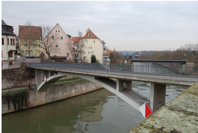
Abb.6.4-3: Unterer Schleusenkanal Lauffen: zu ersetzende Bogenbrücke zur Neckarinsel (rechts im Bild)
