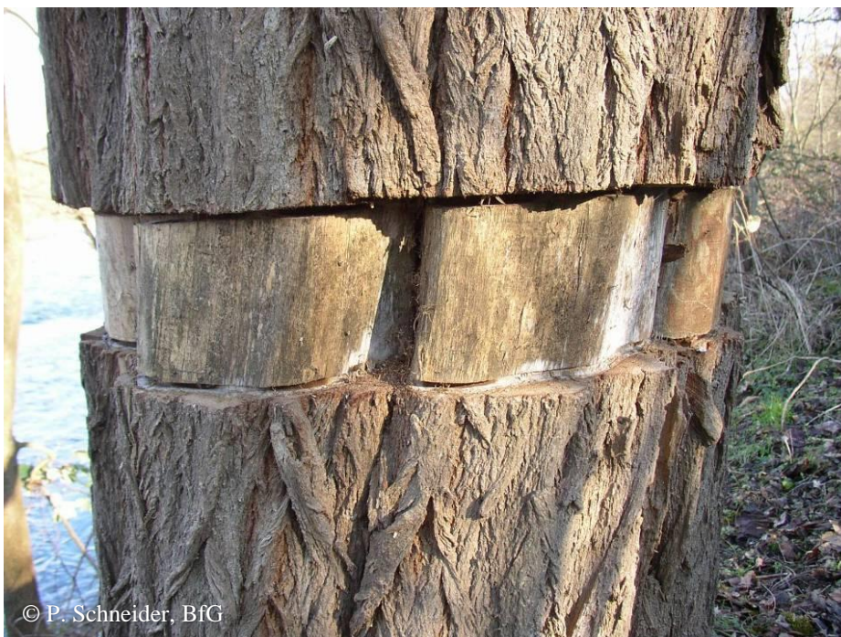
Foto 2: Entfernen von Rinde und Splintholz auch aus schwer zugänglichen Stellen.
