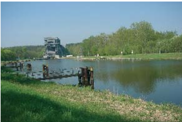
Abb. 36: Bestehendes Schiffshebewerk, Blick vom unteren Vorhafen
