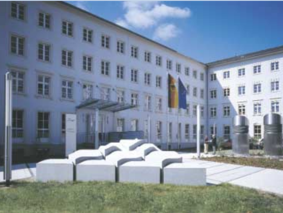
Gebäude II mit Blick auf den Haupteingang
