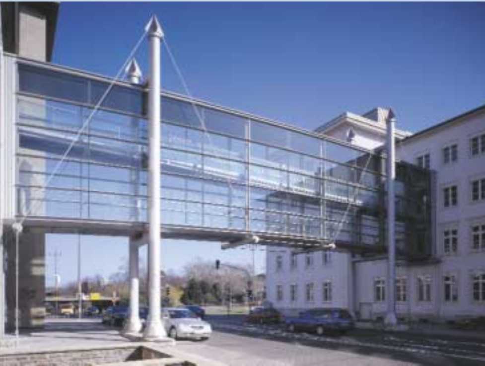
Glassteg (Ansicht von der Mainzer Straße)
