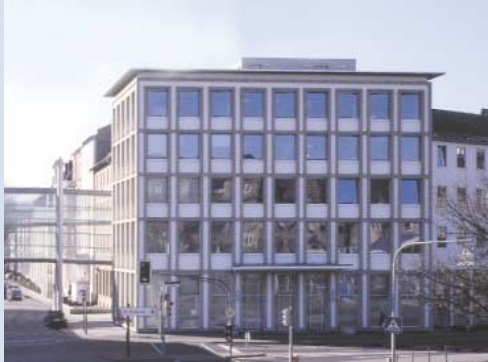
Gebäude I (Ansicht von der Rizzastraße)
