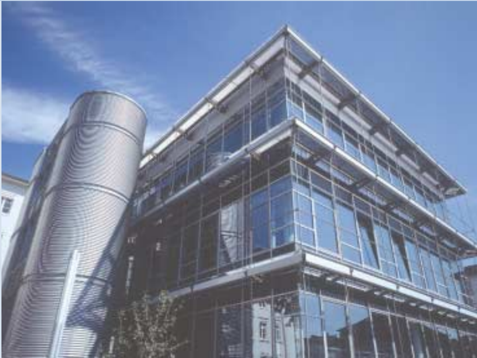
Glasfassade Neubau (Kommunikations- und Bildungszentrum)
