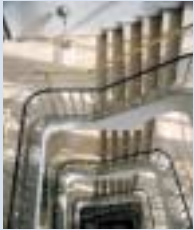
Treppe (Gebäude I)
